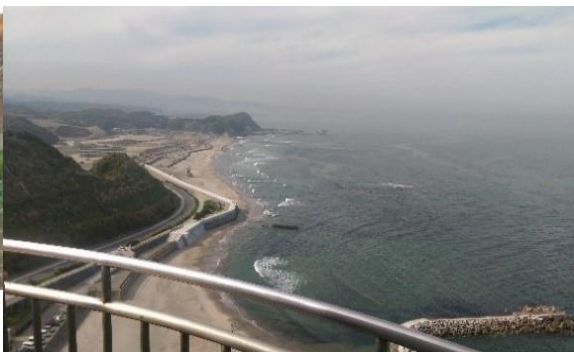
↓いわき市薄磯地区の灯台からの景色。 堤防が建設中であることがわかる。
