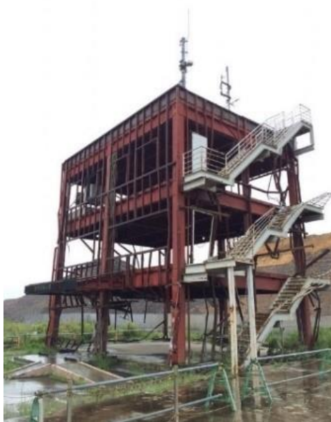
←南三陸町の防災対策庁舎。 屋上の床上2mの高さまで津波にの まれた。
