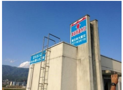
↑陸前高田市にある、津波到達点を示しているビル。
