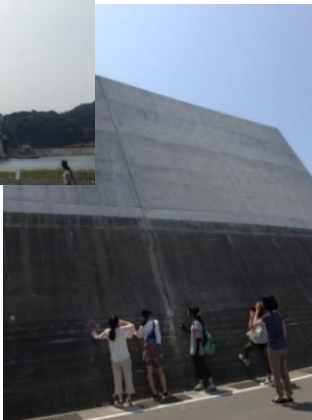
→陸前高田市内の堤防。震災後の工事で12.5mもの高さに建設し直され、町の景観は一変した。
